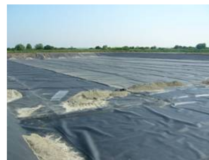
Telatura del fondo con teli in HDPE
