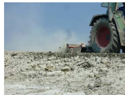
Miscelazione dell'argilla bentonitica
