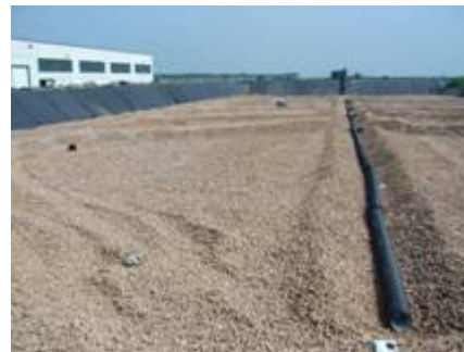
Struttura del fondo della discarica
